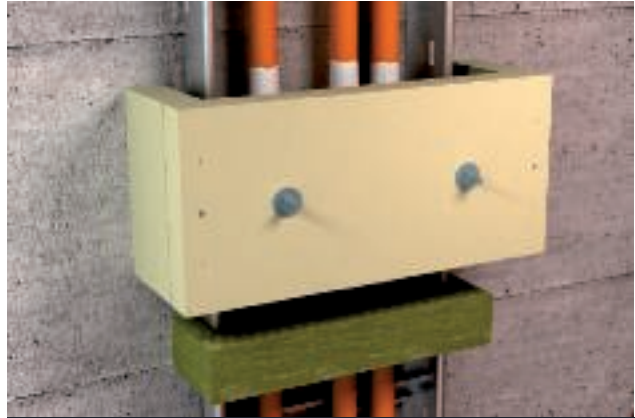
Einbringen der unteren Mineralfaserplatte
